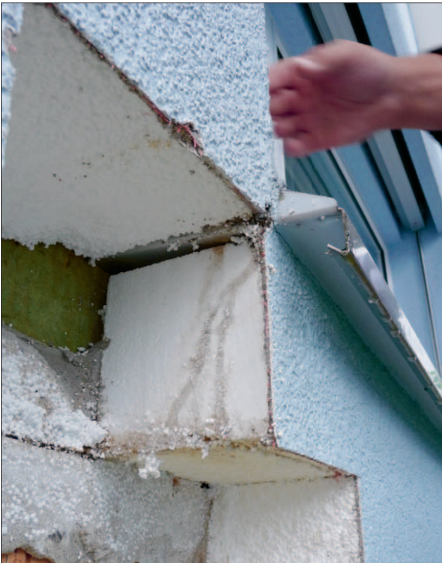
unsachgemässer Fenstersimsanschluss
