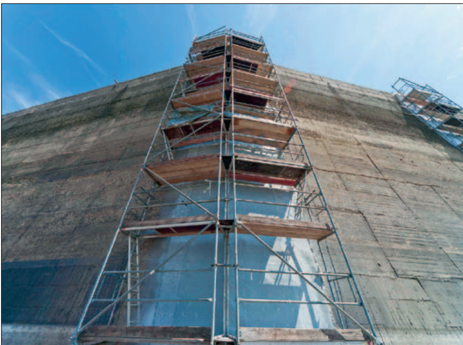
Bild 4: Wasserseitige Blockfugenabdichtung
