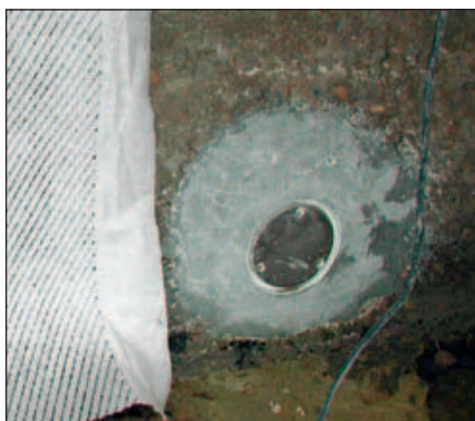
Bild 2: Drainageablauf am Tiefpunkt
