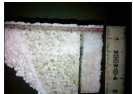
Fassadenstoss mit Spalte
