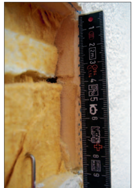
unsachgemässer Plattenstoss
